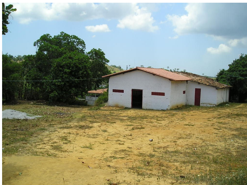
Fig. 03: Vista do barracão no centro do espaço sagrado público do Omo Ilê Aboulá. Data: 08/02/2006.
